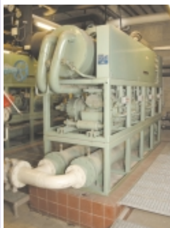
Die beiden Hubkolbenkompressor-Kältemaschinen Baujahr 1980 haben ausgedient.
