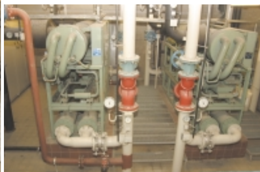
Die beiden Hubkolbenkompressor-Kältemaschinen Baujahr 1980 haben ausgedient.
