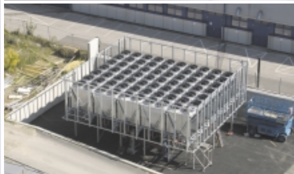
Fünf V-Block Adiabatik-Rückkühler mit einer Gesamtleistung von ca. 4.500 kW.
