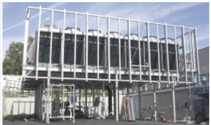
Fünf V-Block Adiabatik-Rückkühler mit einer Gesamtleistung von ca. 4.500 kW.
