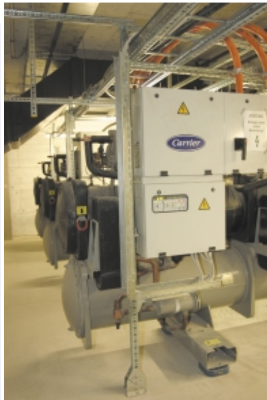
Die drei wassergekühlten Kältemaschinen im LKH Vöcklabruck.
