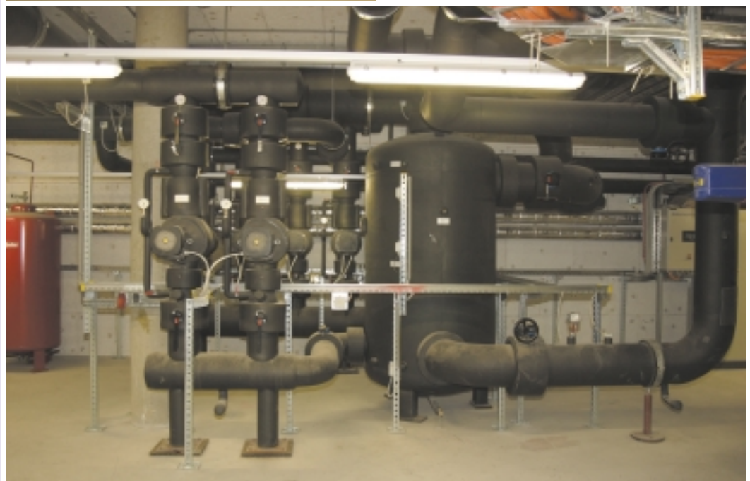
Kaltwasserpufferspeicher und Verteilergruppen.
