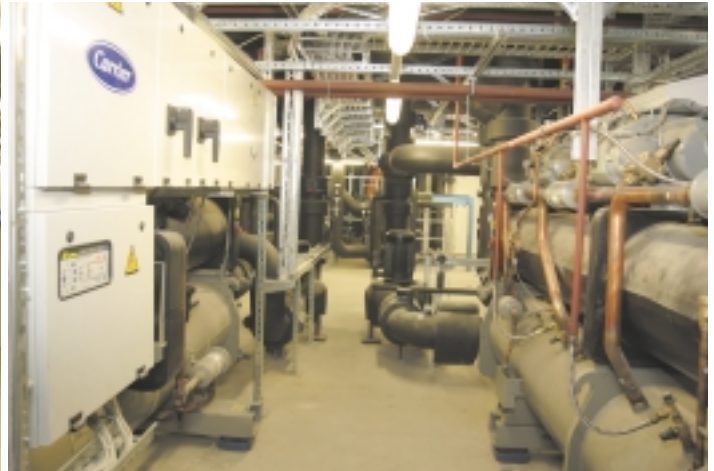
Die drei wassergekühlten Kältemaschinen im LKH Vöcklabruck.
