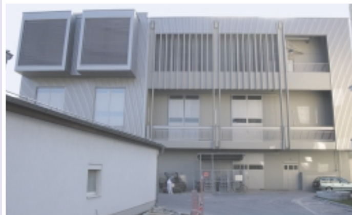
Blick auf die zweistöckige Kälte- bzw. Energiezentrale.
