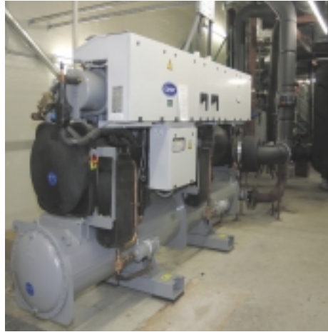
Die Kondensatorwärme der KM 1 wird mittels Brunnenwasser abgeführt.
