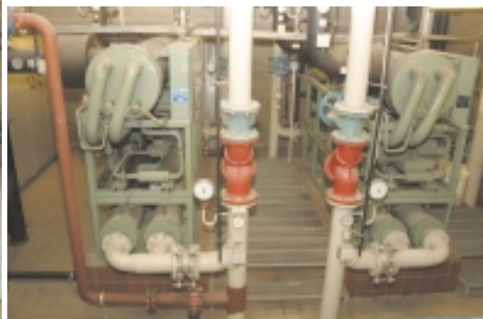
Die beiden Hubkolbenkompressor-Kältemaschinen Baujahr 1980 haben ausgedient.
