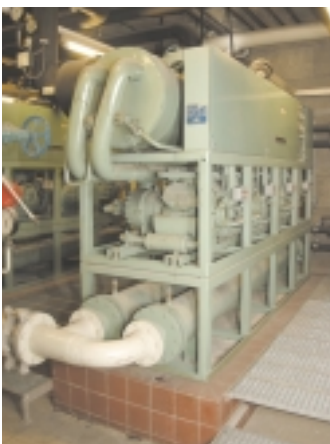
Die beiden Hubkolbenkompressor-Kältemaschinen Baujahr 1980 haben ausgedient.
